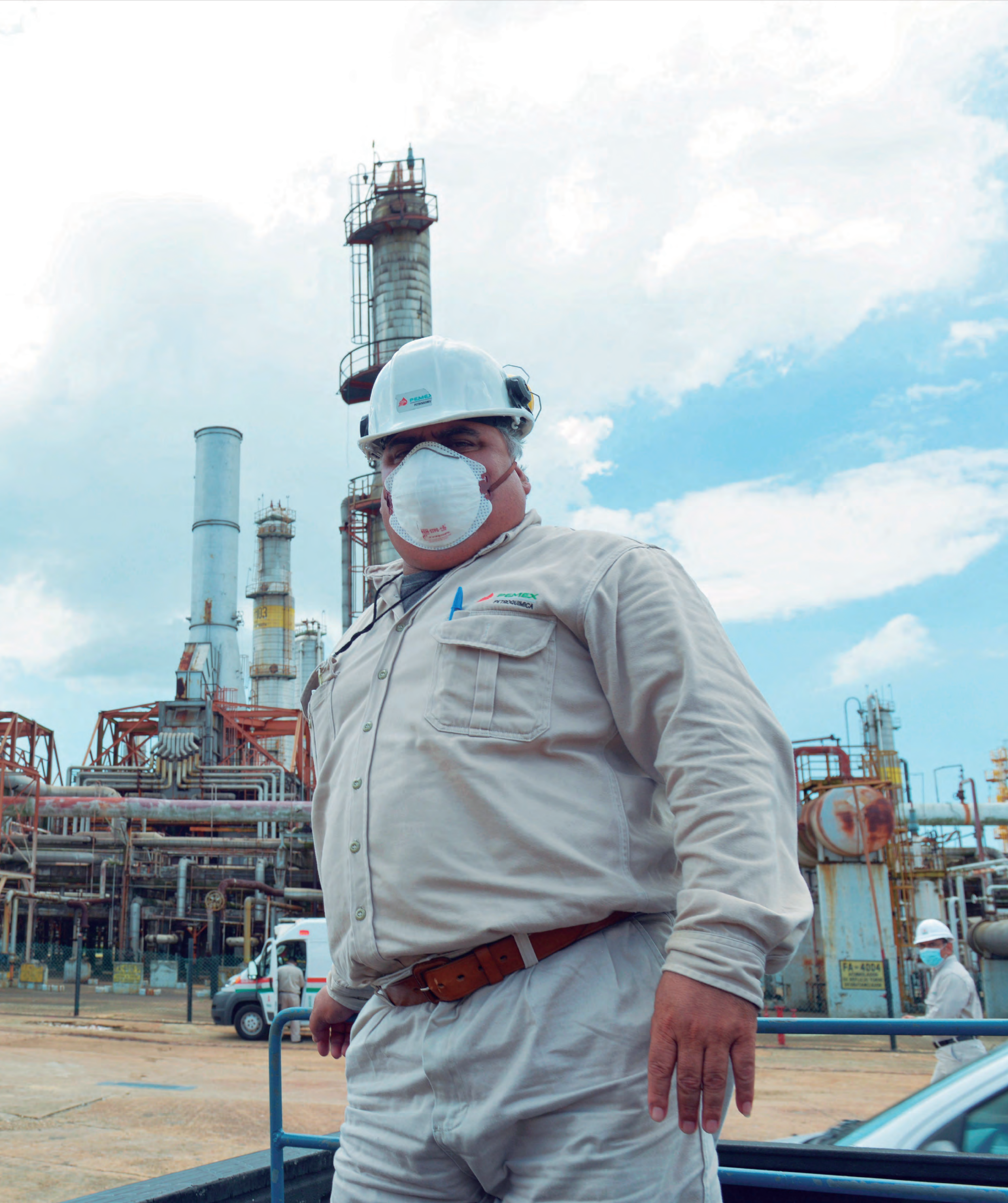
Fotografía 14. Central Termoeléctrica Salamanca, en Salamanca, Guanajuato. 6 de junio de 2020. Comisión Federal de Electricidad.
