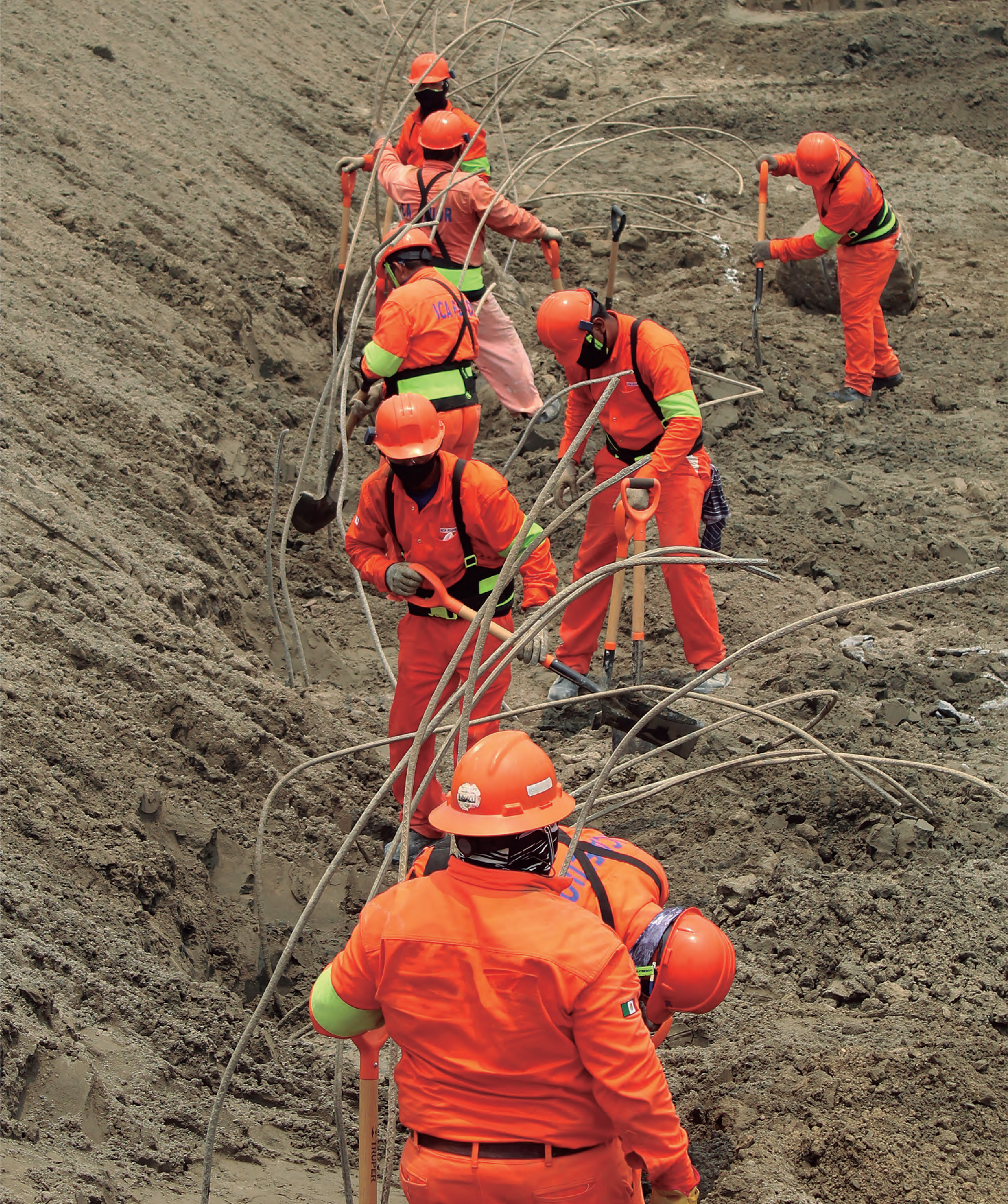
Fotografía 6. Trabajos de construcción en la nueva refinería en Dos Bocas, Paraíso, Tabasco. 06 de mayo de 2020. Secretaría de Energía.
