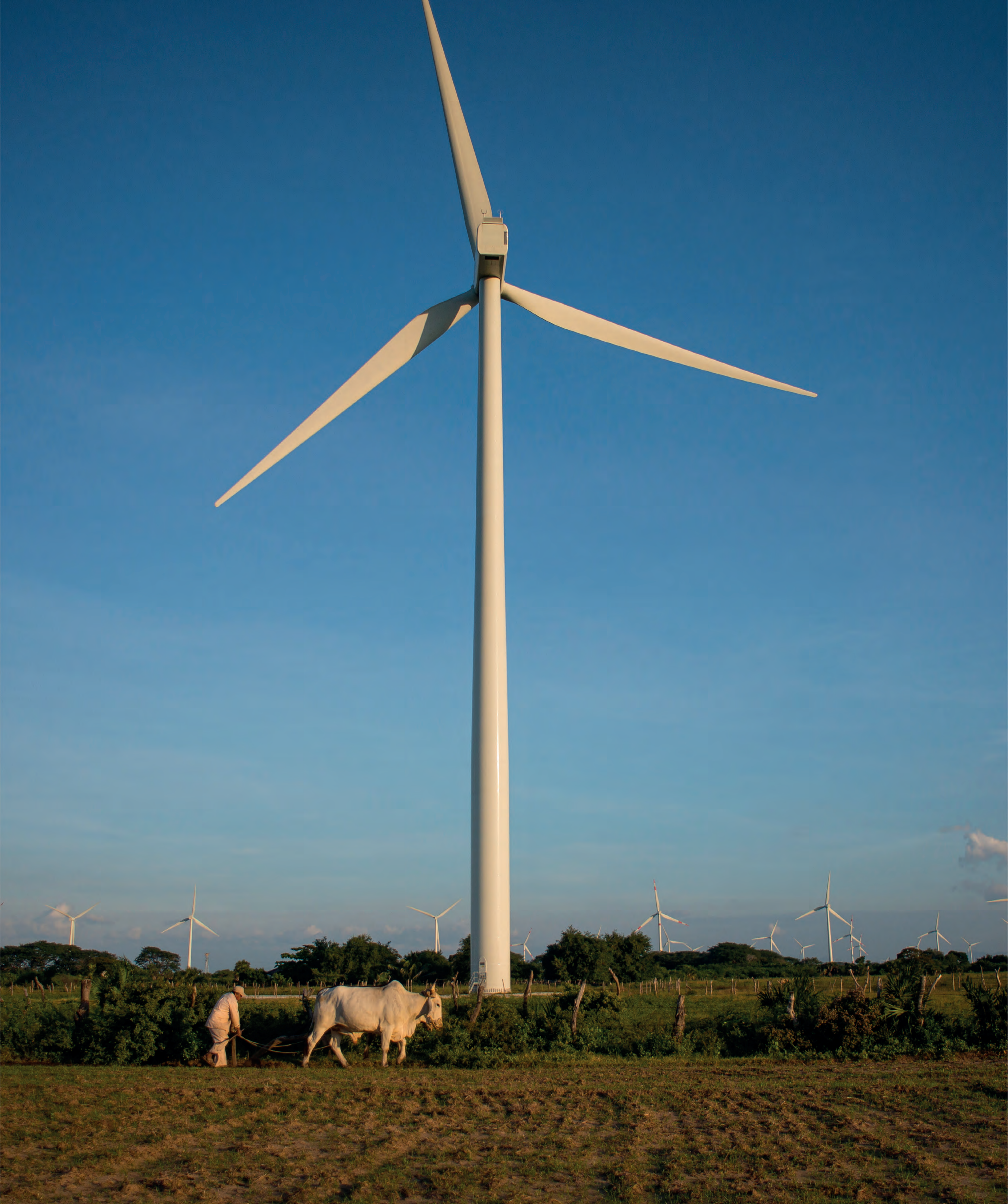
Fotografía 10. Complejo eólico Oaxaca, Istmo de Tehuantepec. Comisión Federal de Electricidad.
