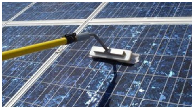
Figura 4.1. Limpieza de paneles
