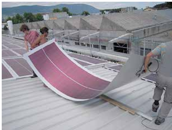
Fig. 3: Módulo de silicio amorfo [3]
