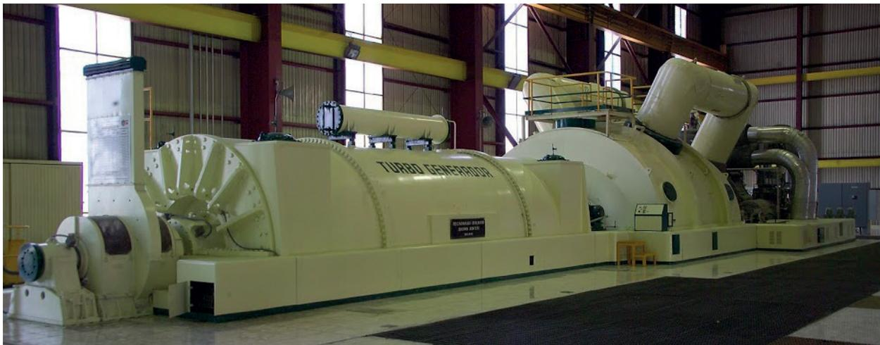
**Fotografía 8.** Turbogenerador, Central termoeléctrica, "Salamanca". Salamanca, Guanajuato. CFE.
